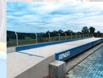
Balança Rodoviária Convencional com vigas
